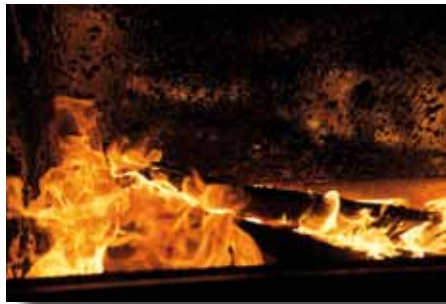
Die Holzheizung gilt als CO 2 -neutral, da mit einheimischem Rohstoff betrieben.
