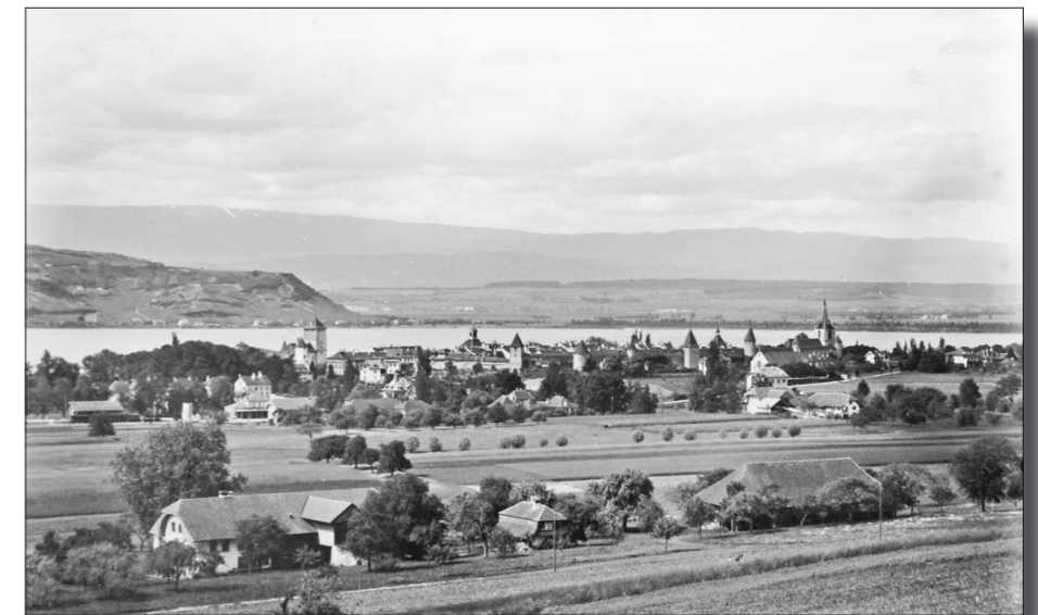
Der freiburgische Markt Flecken Murten zählte 1866 knapp 2300 Einwohner; hier eine Aufnahme (von Gustav Wattelet) um 1900 mit Blick auf Murtensee und Mont Vully. Bild: Museum Murten
