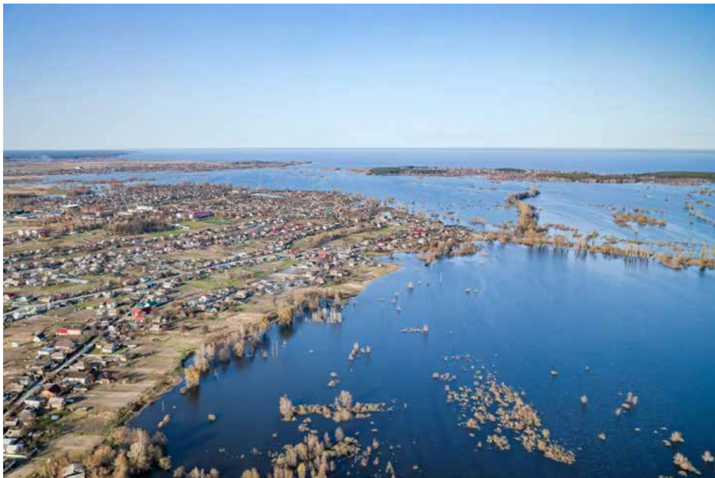
Der beschädigte Irpin-Damm und die überflutete Landschaft um das Dorf Demydiv nördlich von Kiew, Ende Februar 2022. © Vincent Mundy
