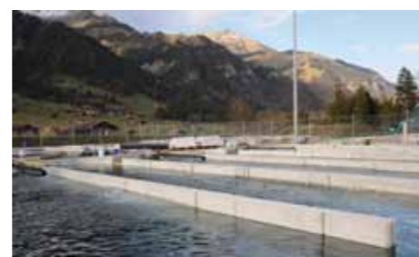
Die für Besucher einsichtbaren Aussenbecken der Zuchtanlage.
